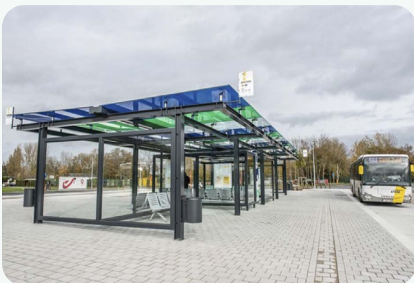
Hoppinpunt: wachtruimte en bushalte, in Gavere
